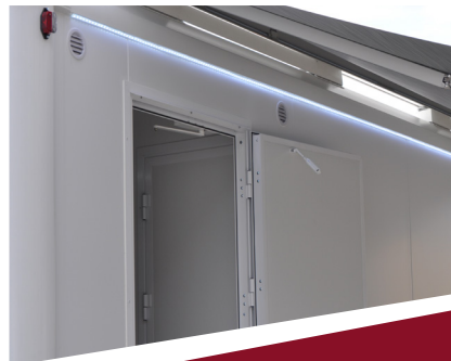
Eclairage LED extérieur bandeau
